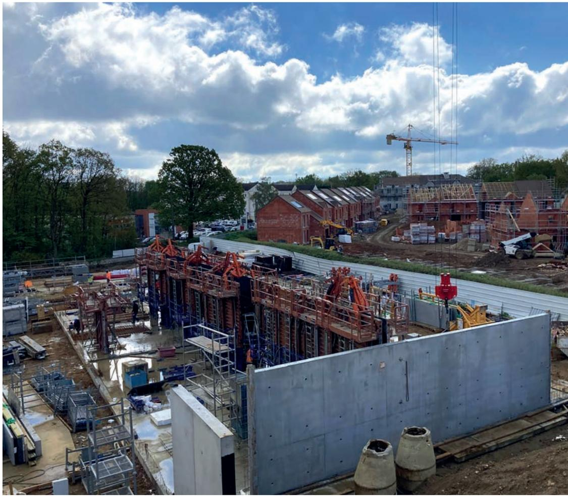
Les fondations et le niveau sous-sol sont maintenant achevés. Le coulage de la dalle du rez-de-chaussée du groupe scolaire est en cours de réalisation. La commune apprécie particulièrement la qualité des ouvrages, l'accessibilité et la propreté du chantier géré par l'entreprise ZUB et son groupement.
